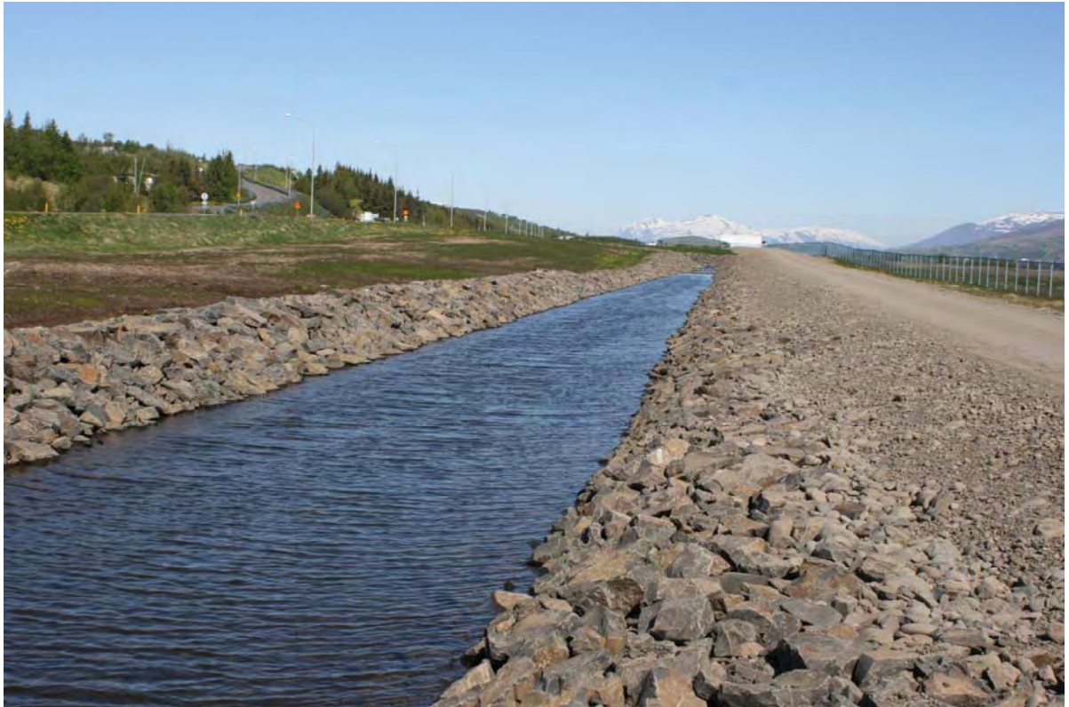
4. mynd. Nýr farvegur Brunnár vestan flugvallar. Við lengingu Akureyrarflugvallar var áin leidd í skurð suður með flugvelli og fyrir enda hans út í Eyjafjarðará. Ljós. Sverrir Thorstensen, 7. júní 2010.
