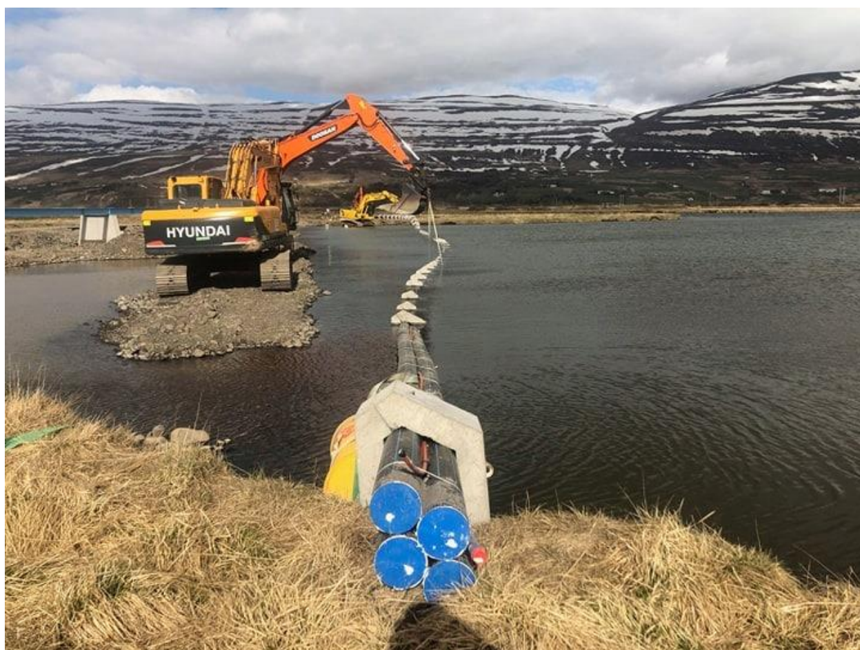
MYND 3.9 Lagning ídráttarröra í vesturkvísl Eyjafjarðarár í maí 2020.
