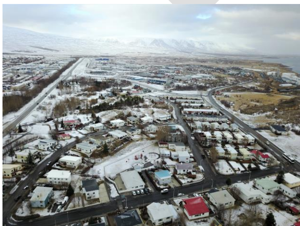
Mynd 20. Núverandi byggð
